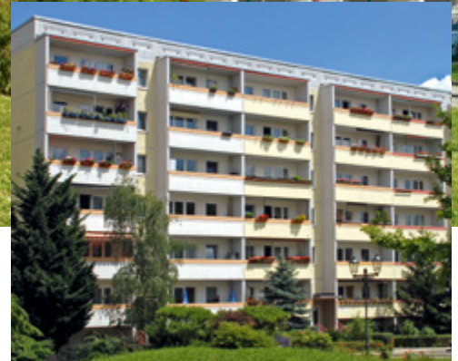
Vor und nach den Baumaßnahmen Karl-Holz-Straße
